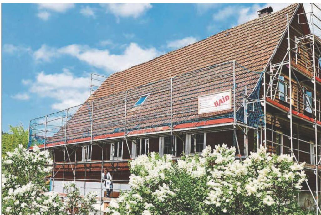
Das Leibgedinghaus des 238 Jahre alten Bachbauernhofs in Ehlenbogen wird umgebaut.
