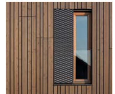
Optimaler Holzschutz: Grundierung und zwei Anstriche mit wasserbasierender Holzölbeschichtung. Natürliche Optik: Schattierung der Oberfläche durch Verwendung von verschiedenen Farbtönen.
