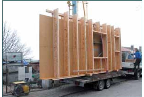
Tragende Holzelemente werden in hohem Maße vorgefertigt und sind leicht zu transportieren. Dadurch werden kurze Bauzeiten gewährleistet.
