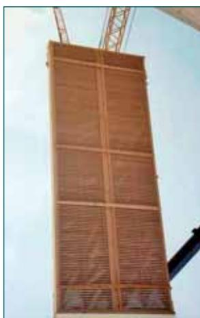
Zeitsparende Montage der werksseitig vorgefertigten, großflächigen, schallabsorbierenden Dachelemente; sie sind als Folienabsorber so ausgelegt, dass der beim Starten der Einsatzfahrzeuge auftretende tieffrequente Schall absorbiert wird, so dass im hektischen Einsatzfall immer noch eine gute Sprachverständlichkeit gegeben ist.
