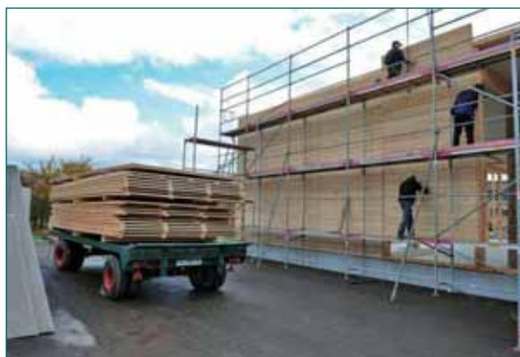
Montage der vorgefertigten Fassadenelemente; für ca. 400 m<sup>2</sup> wurden insgesamt lediglich 30 Mannstunden und zehn Kranstunden benötigt.
