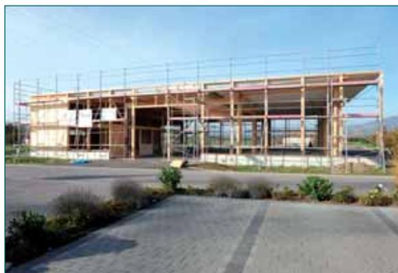
Unverkleidetes Holzskelett mit bereits verlegter Dachschale
