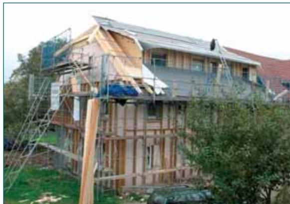
Das Beispiel „Sanierung eines Bauernhauses“ zeigt eine weitere Einsatzmöglichkeit von Holzwerkstoffen als Tragkonstruktion.
