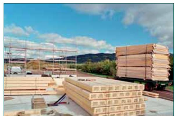
Industriell vorgefertigte Lignotrend-Deckenelemente für den Werkstatt/Büro-Trakt, die tragen, dämmen und Schall absorbieren und zeitsparend in einem Arbeitsgang verlegt werden.
