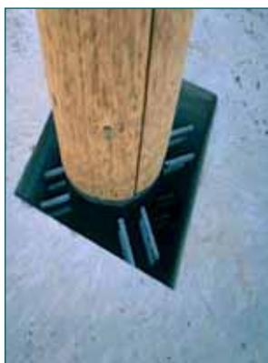
Lastübertragung durch Stabdübel, Feuchteschutz durch Bitumenbeschichtung
