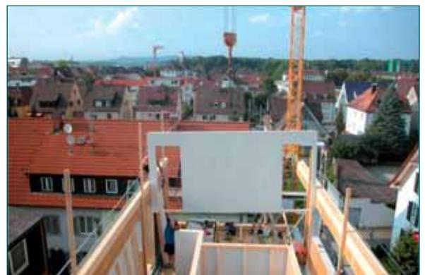
ten Holzskelettkonstruktion möglich. Der neue Gebäudekörper wurde als Brücke ausgebildet. Unter diese Konstruktion wurde ein schachtelförmiges Modul quasi „angehängt“. Im Ergebnis sind zusätzliche private Wohnräume, Abstellräume und Gewerberäume entstanden, die in massiver Bebauung so hätten nicht realisiert werden können. Hier erfüllt der Baustoff Holz die Anforderungen in den Bereichen Schall- und Brandschutz in besonderem Maße.
