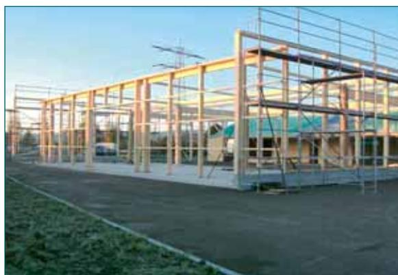
Holzkonstruktion am Ende der ersten Montageweche; durch die eingespannten Tannenstämmen sind keinerlei Aussteifungsverbände notwendig.
